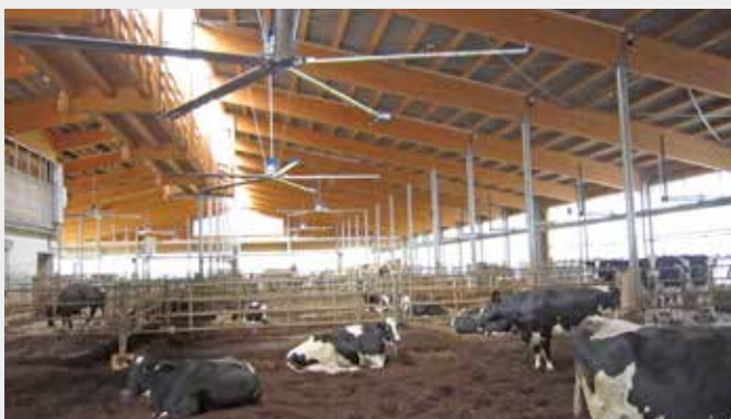
Großraumventilatoren haben einen sehr eingeschränkten Wirkungsbereich Feiner Sprühnebel kühlt die Stallluft
