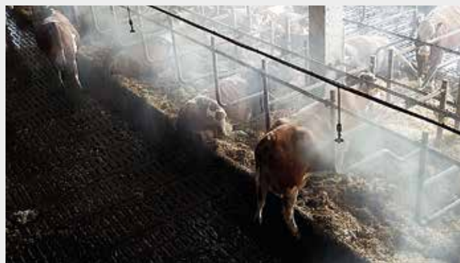
Großraumventilatoren haben einen sehr eingeschränkten Wirkungsbereich Feiner Sprühnebel kühlt die Stallluft
