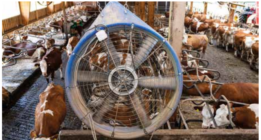
Der Betrieb hat am Projekt „Luftqualität im Kuhstall“ von LFZ Raumberg-Gumpenstein und der Firma DeLaval teilgenommen. 7 Ventilatoren sorgen für frische Luft im Stall
